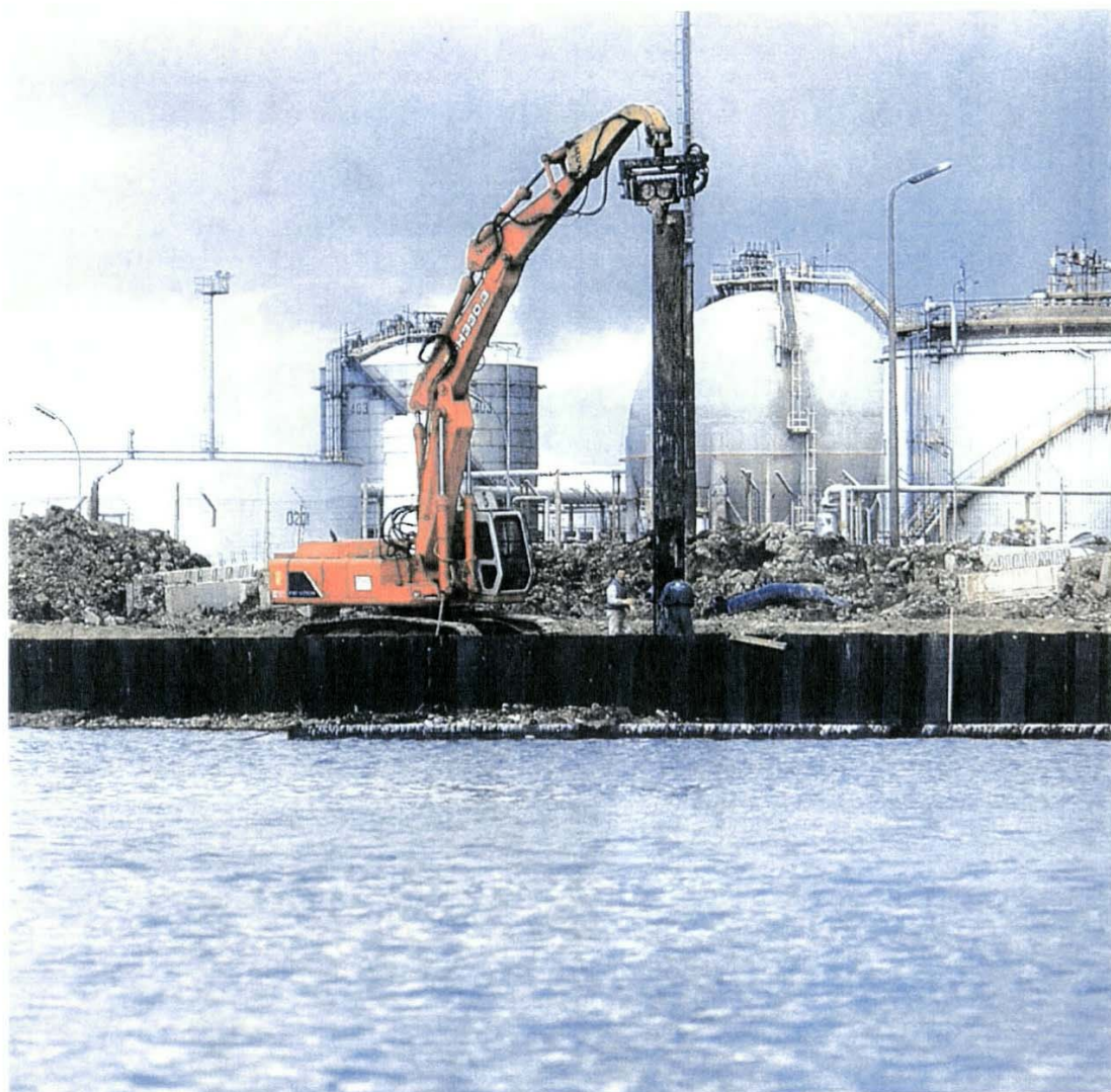
Infissione del palancolato di acciaio a ridosso della riva preesistente
