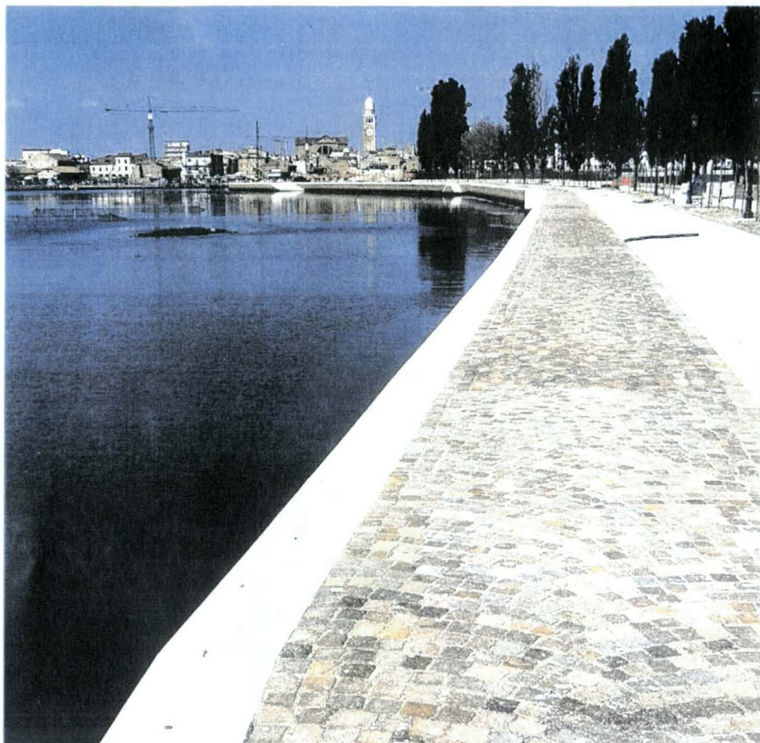
Lungo l'intera estensione delle rive sono stati predisposti un marciapiede con pavimentazione di cubetti di porfido e una pista ciclabile con pavimentazione di lastre di trachite, che rendono continuo il percorso tra Chioggia, Borgo San Giovanni e Sottomarina, completando quello predisposto attorno al bacino del Lusenzo
