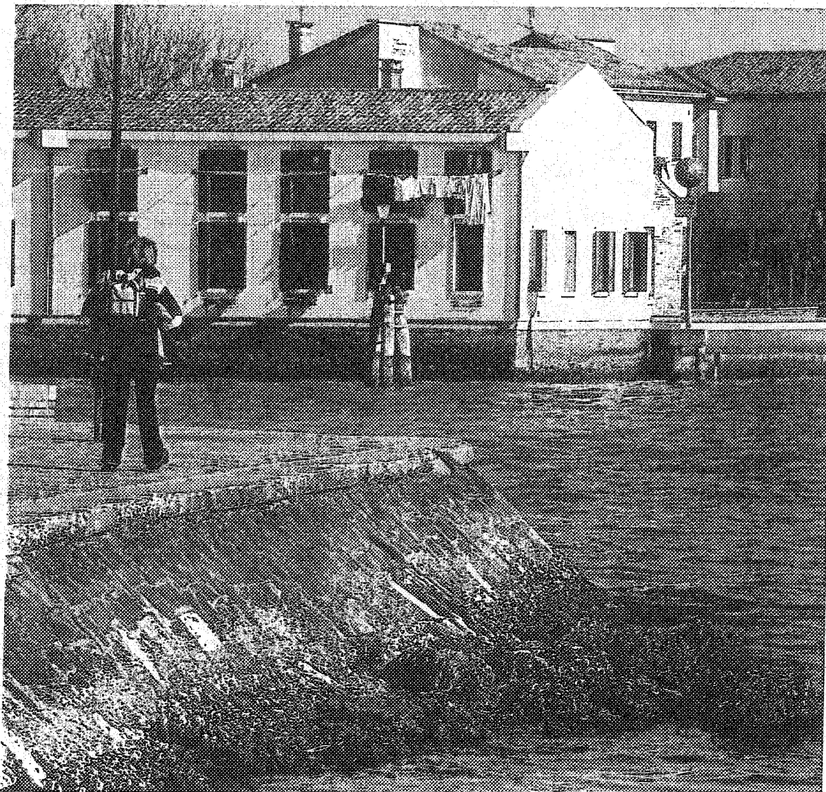
Un tratto di riva prima dei lavori
