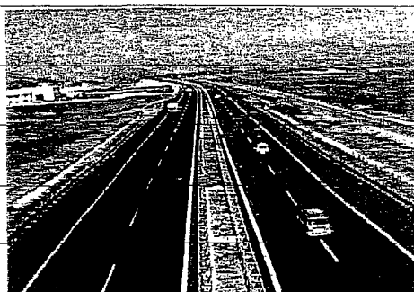
Autostrada SA-RC lotto 2° ultimato
